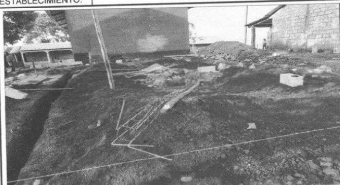
Foto 1: Se observa el inicio de la ampliación de la cocina.
