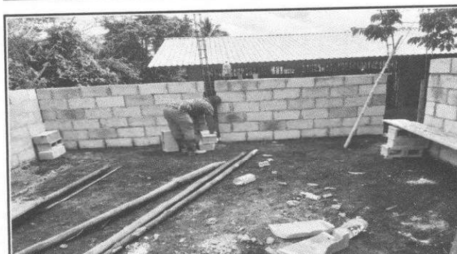
Foto 4: Se observa un 40 % del avance del trabajo.
